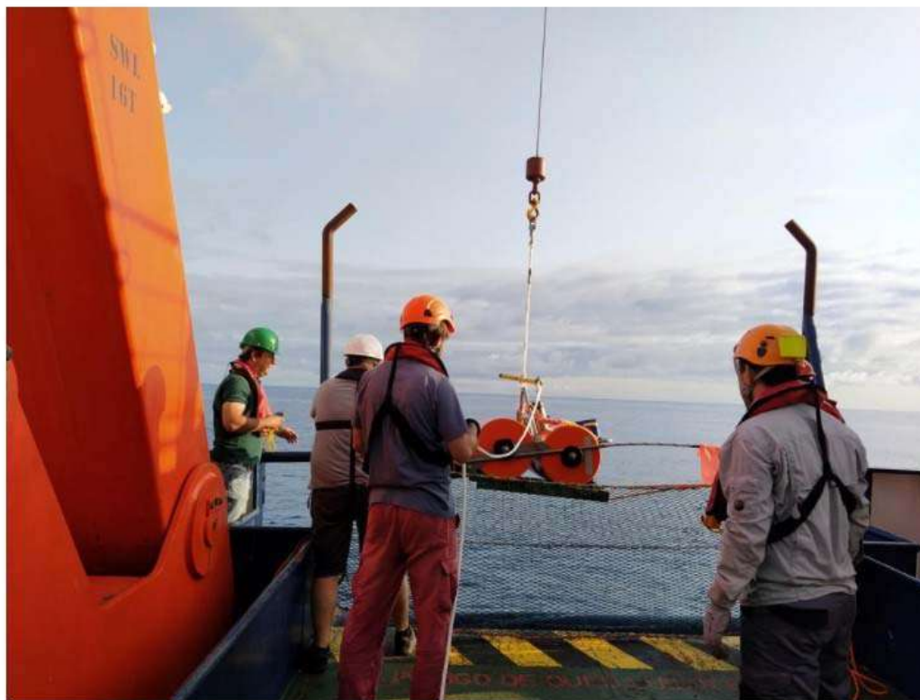
Lançamento ao mar de um dos sismómetros submarinos DIR.
